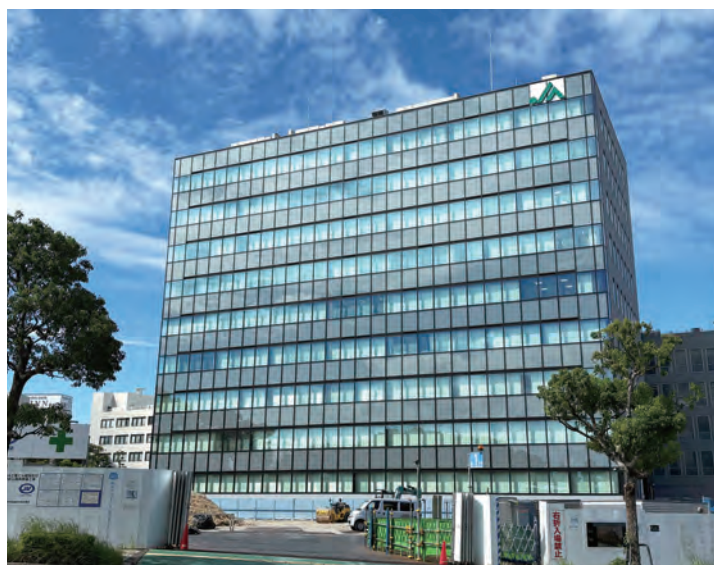
令和7年7月より入居の新JA三重ビル
