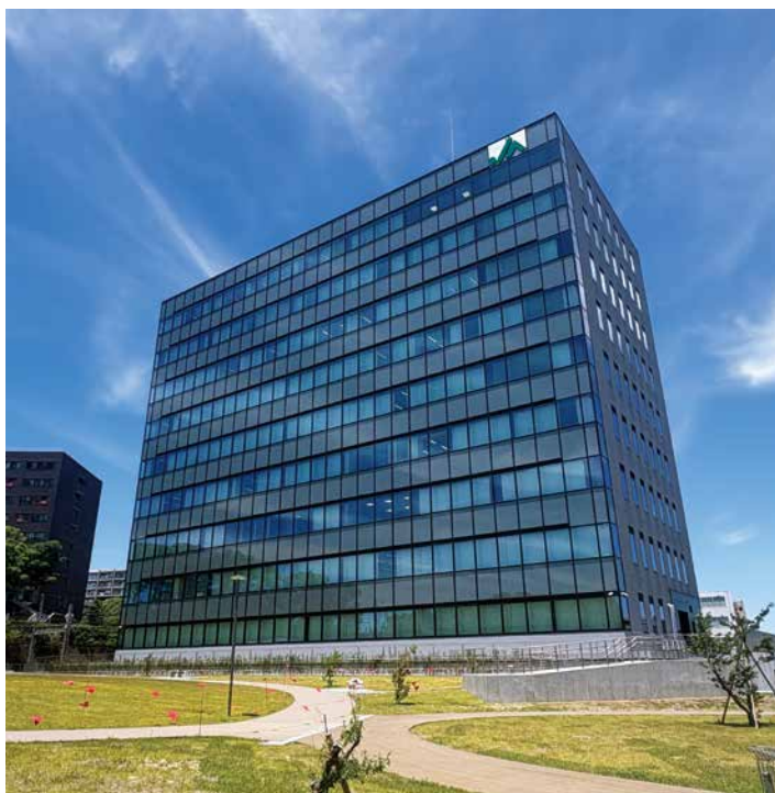
令和7年7月に新設移転した新JA三重ビル
